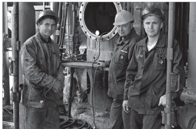
Слюсарі-ремонтники УКР В.О.Тараненко, А.Д.Романенко, О.М.Андрейко під час ремонту збірника вуглеамонійних солей
