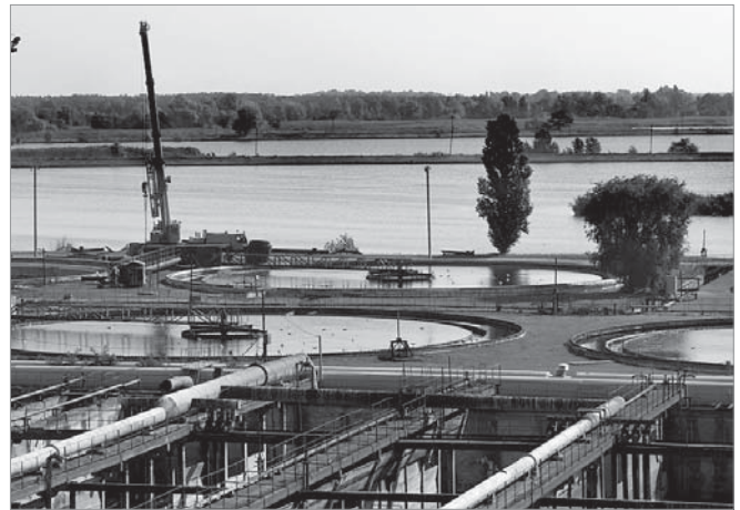
Очисні споруди ПАТ «АЗОТ» є найкращими в басейні Дніпра
